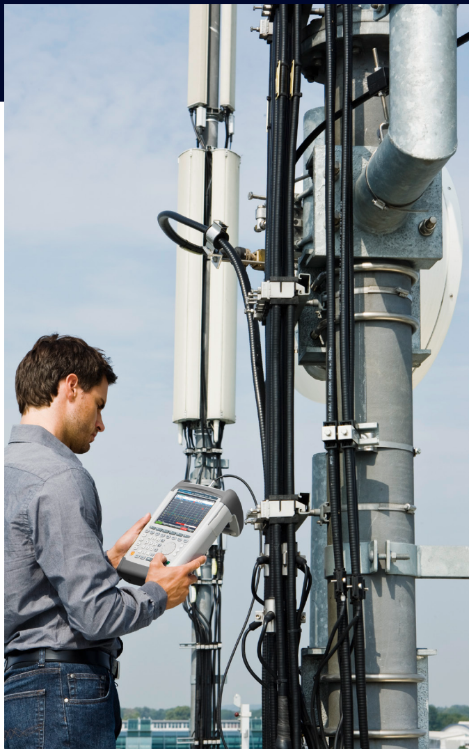
Kabelfehlstellenortung an einer Mobilfunkantennenanlage mit dem R&S®ZVH
