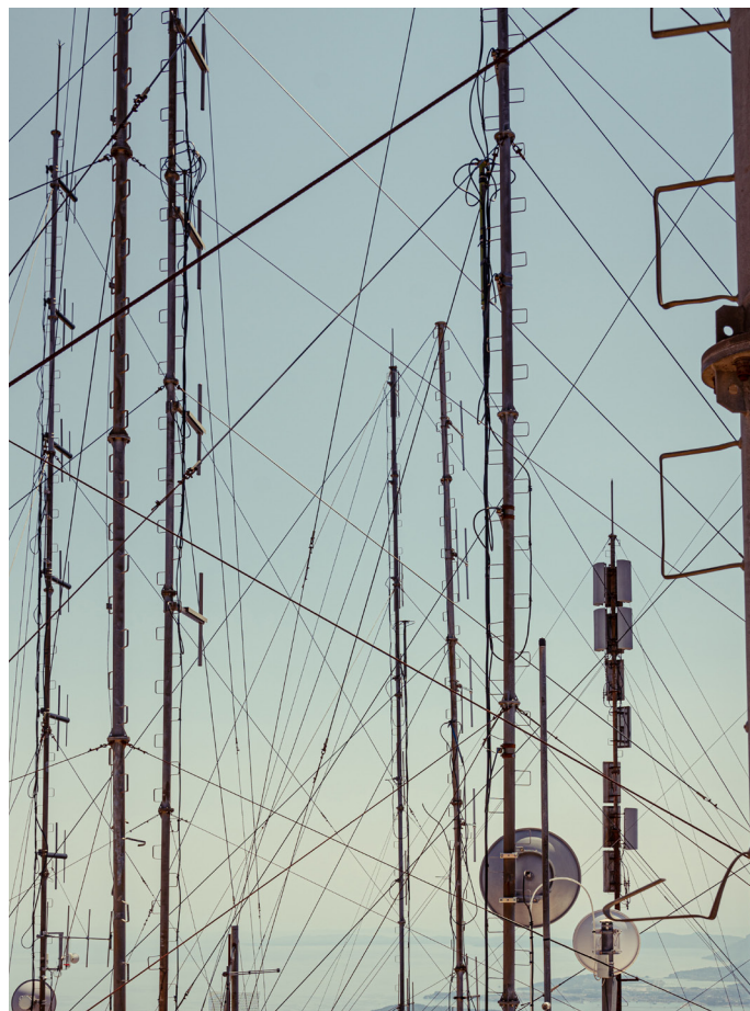
Bild 3: Dipole Phased-Array-Antennen [2]
